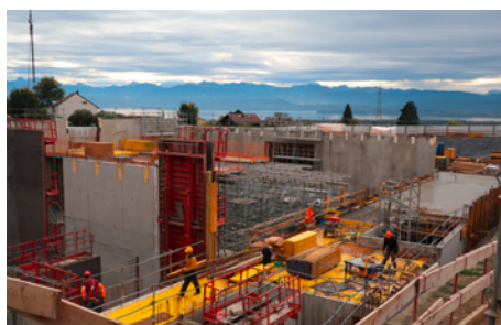
Les travaux se poursuivent selon le planning établi.
